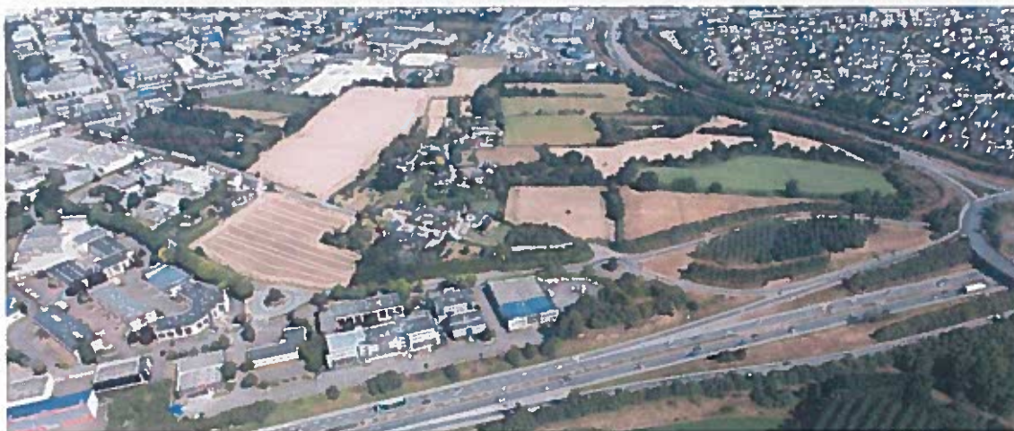
Figure 4 : Vue aérienne de la ZAC
